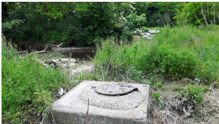
Figura 58–pozzetto della fognatura intercomunale in sinistra idraulica
