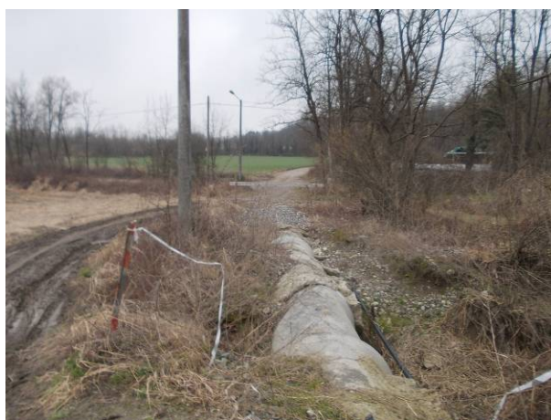
Figura 27 – particolare della condotta di troppo pieno scoperta sotto via dell'Abbazia
